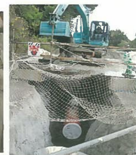
立坑直上鋼管設置
